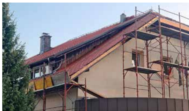
Prenova strehe na krajevnom domu
