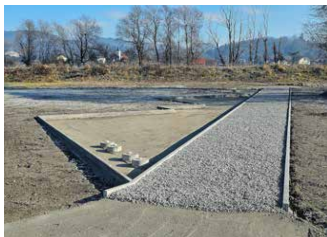
Objekt po končani prvi fazi gradbenih del
