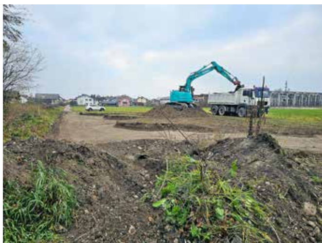
Zemeljski odkop vrhnjega sloja zemlje
