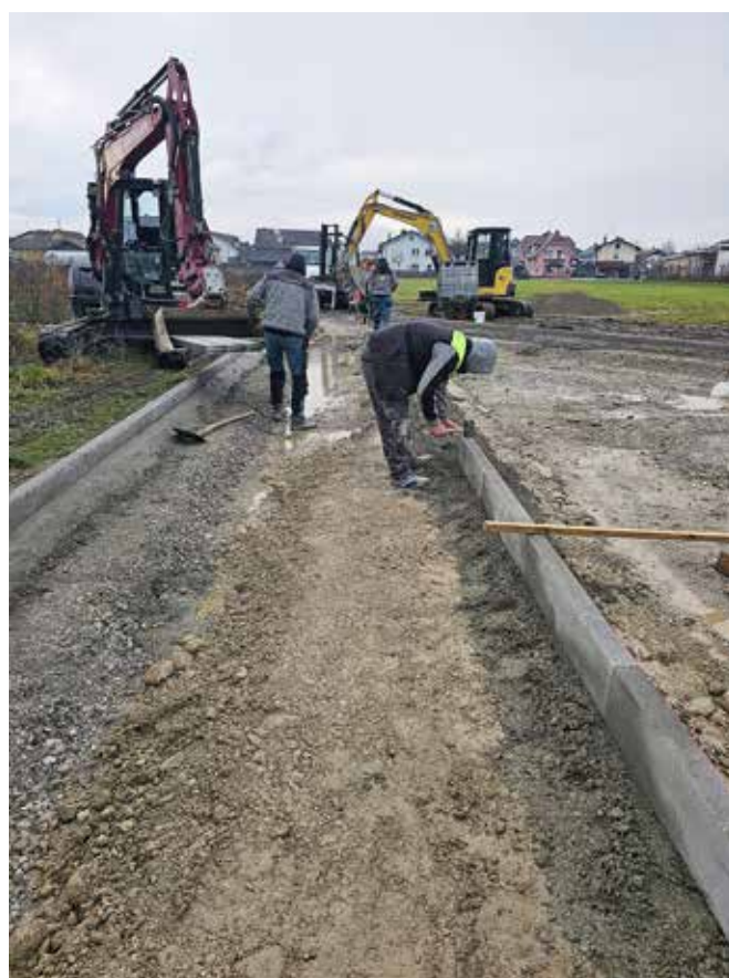
Vgradnja betonskih robnikov na betonsko peto
