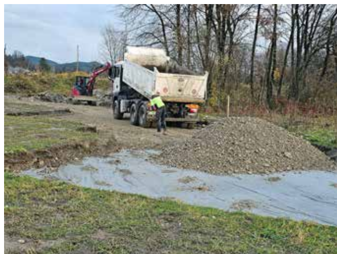
Vgradnja kamnite grede kot spodnji ustroj
